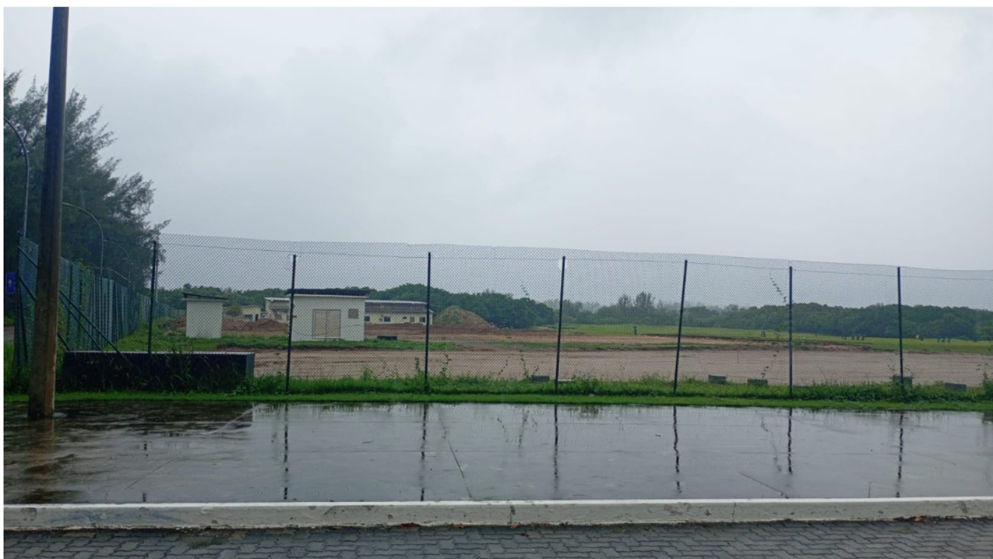
VISTA DA ÁREA SOB INTERVENÇÃO NO SENTIDO LONGITUDINAL
