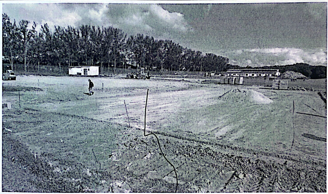
Fig. 04. Visão do canteiro de obra das intervenções realizadas, com detalhe para os operários ainda trabalhando no local e presença de insumos ligados a construção civil no local como tijolos, areia e brita (trecho 01).
