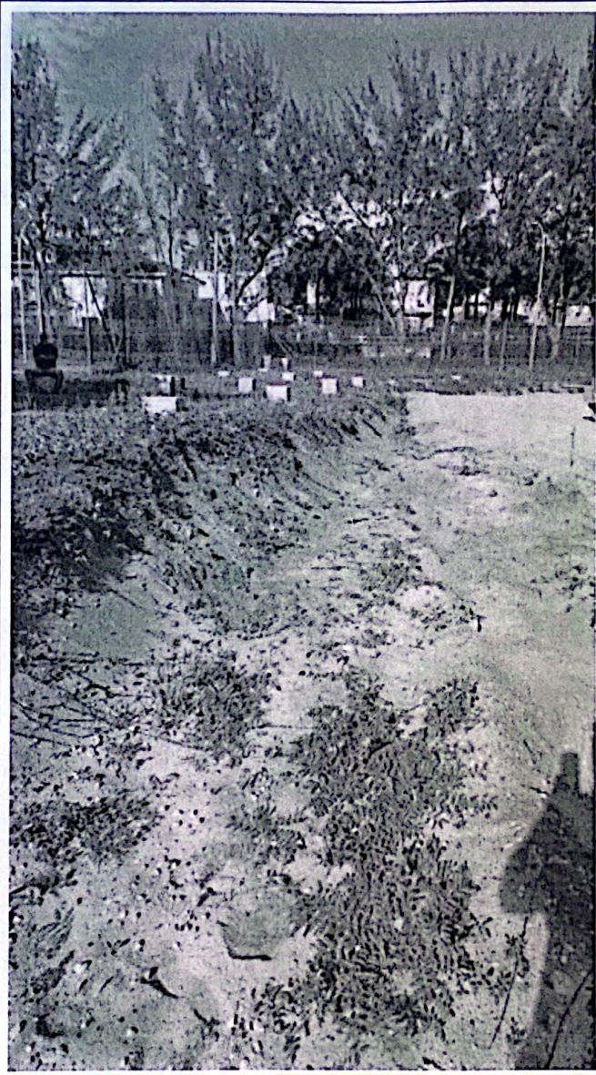
Fig. 11. Visão de corte de terreno, gerando cota de até 1,0 metros abaixo do nível original, localizado no trecho 1, não sendo identificado o destino desse material.
