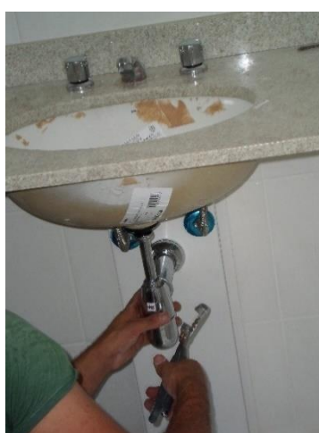
Figura 27 - Instalação de louças e metais (serviço com tempos úteis e ociosos)
