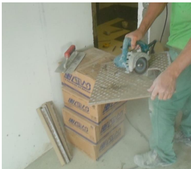
Figura 29 - Exemplo de serviços onde o levantamento do valor da perda, com base na apropriação das sobras de peças não utilizáveis
