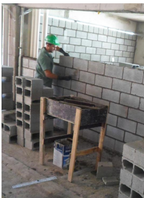
Figura 28 - Assentamento de Blocos com argamassa
