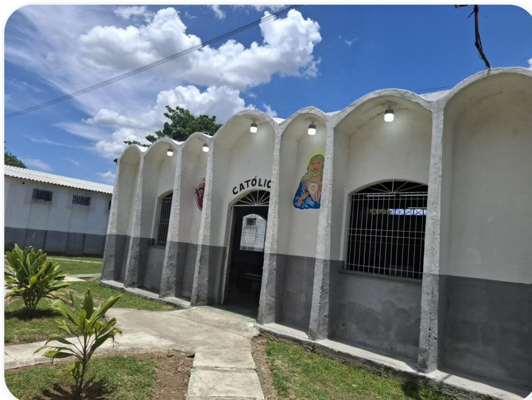
Figura 12: Foto da igreja católica construída
