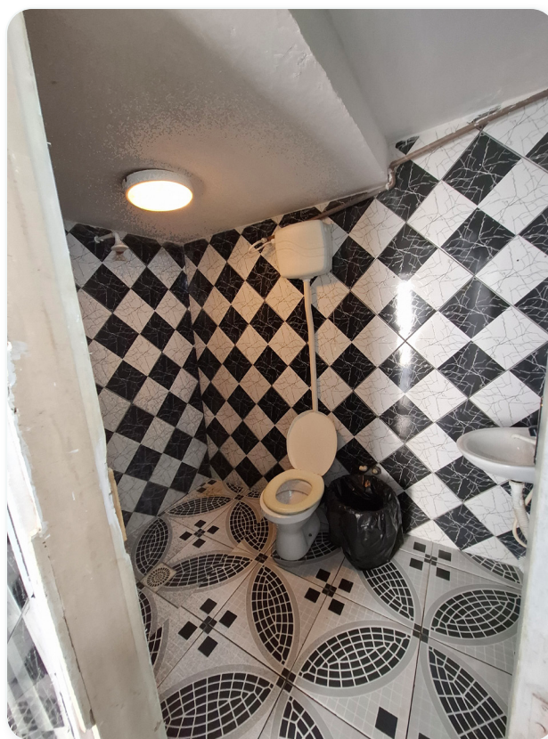
Figura 15: Foto de banheiros para visitantes
