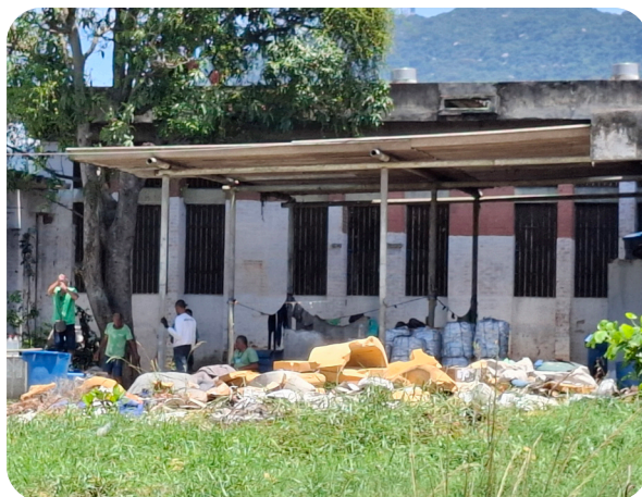
Figura 19: Posto de vigilância desativado, próximo ao Pavilhão E
