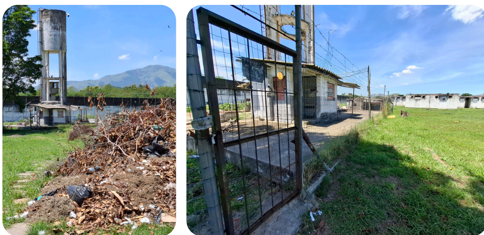
Figura 14: Espaço aberto próximo à torre de água com muito acúmulo de lixo
