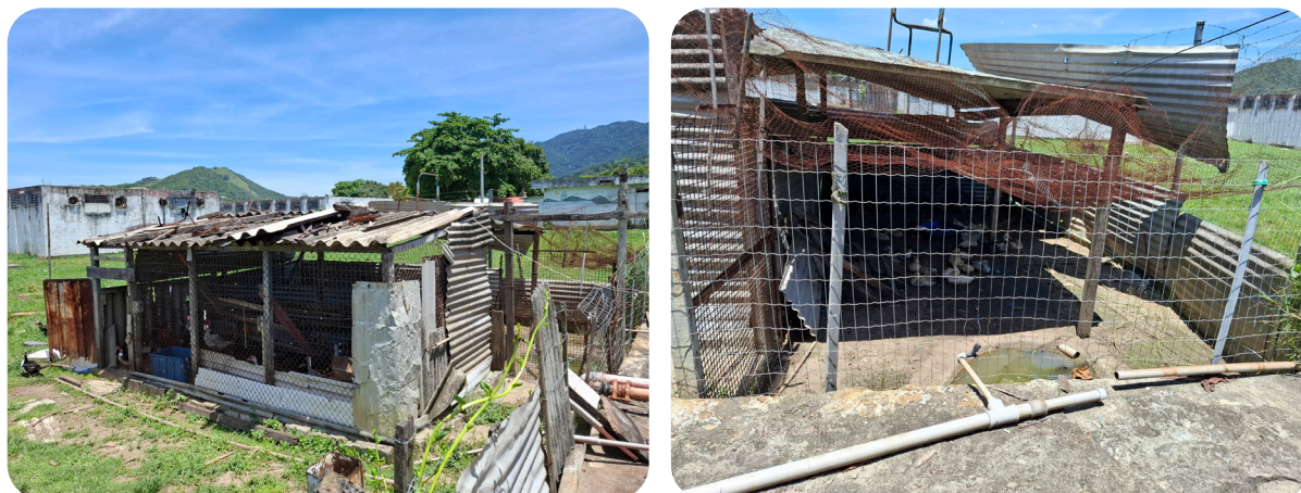
Figura 16: Criação de aves improvisada, próximo à torre de água, possível contaminação de água
