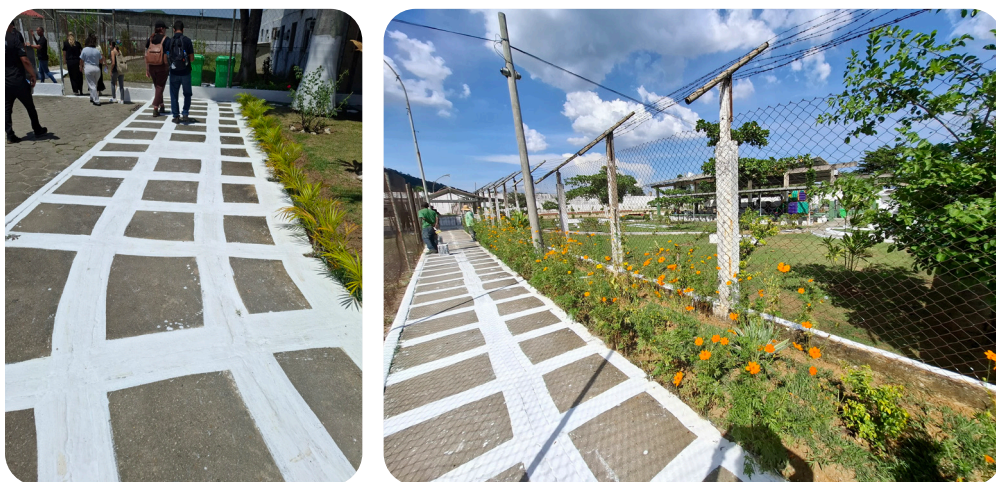
Figura 10: Pintura de demarcação dos passeios nas áreas abertas da unidade
